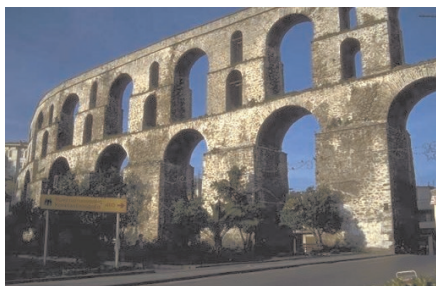
Aqueduto: seqüência de arcos romanos (arcos semi-circulares ou de pleno centro)
